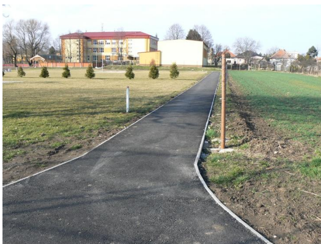
Prístupový chodník, smer futbalové ihrisko – Základná škola
